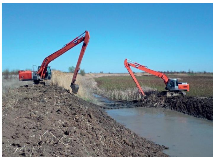
Рисунок 8 – Работы по созданию оросительного канала в Астраханской области, 2022 год
